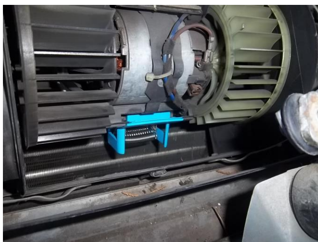
Mise en place du nouveau bloc résistances et remonter les garnitures.
